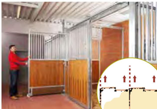
3 Avec une cloison coulissante, les chevaux peuvent séjourner dans l'allée d'écurie pendant l'enlèvement du fumier.
