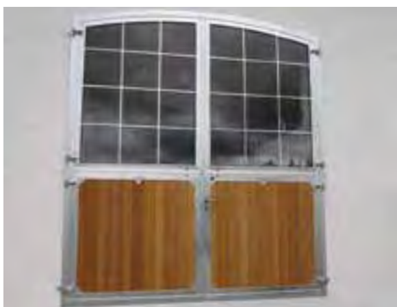
1 Portail rotatif en arc bombé 2 battants, peinture thermolaquée, remplissage en bambou, vitrage sécurité, croisillons posés 2 Portail rotatif en arc bombé 2 battants, acier galvanisé, remplissage en bambou, vitrage sécurité, croisillons posés 3 Portail rotatif en arc bombé 3 battants, acier galvanisé, remplissage en bambou, vitrage sécurité, croisillons posés 4 Portail rotatif en arc bombé 4 battants, acier galvanisé, remplissage en bambou, vitrage sécurité, croisillons posés 5 Portail rotatif en arc bombé 2 battants, acier galvanisé, remplissage en bambou, fenêtre en losange, division opt. du portail
