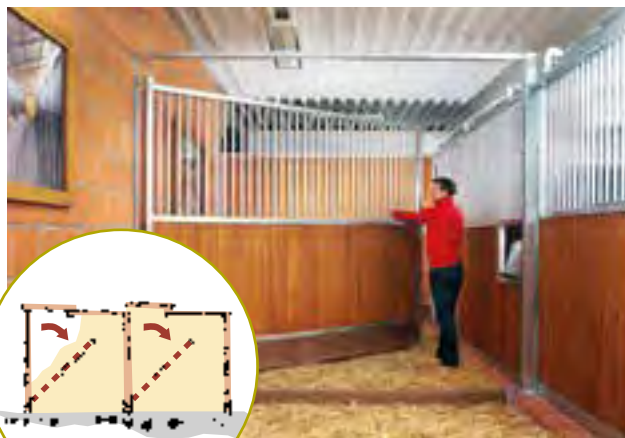
2 Les cloisons pivotantes conviennent à l'enlèvement du fumier dans des rangées de box entières.
