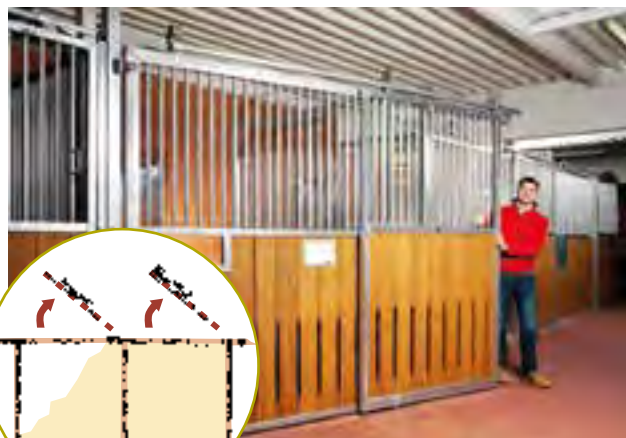
4 Sollen einzelne Boxen von vorn mit dem Knicklenker gemistet werden, ist die schwenkbare Vorderwand eine ideale Lösung.
